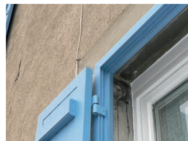
Profil de finition avec joint adaptable qui masque le jour autour de la menuiserie.
